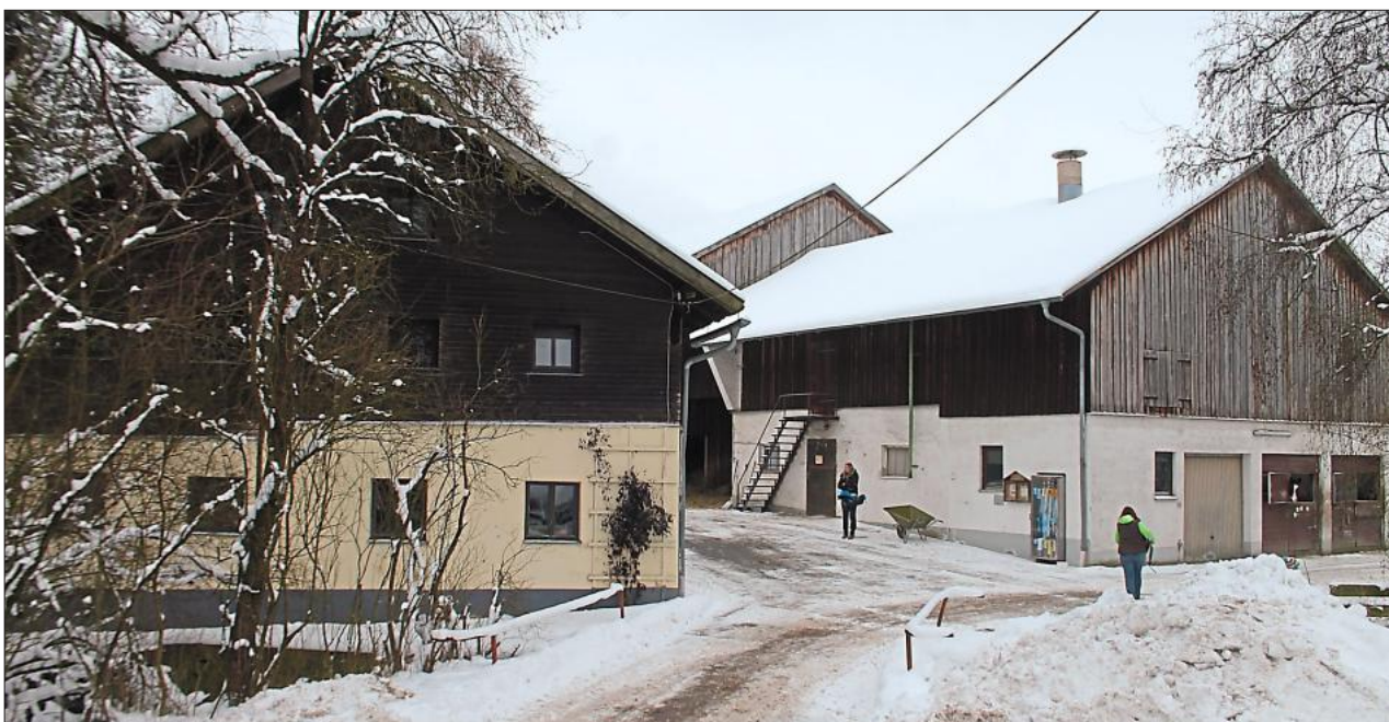
Das denkmalgeschützte Wohngebäude der Bruckmühl wird das neue Zuhause von Bernd Hackl, seiner vierköpfigen Familie, seinen vier Hunden und Co-Trainerin Kerstin Rester.
